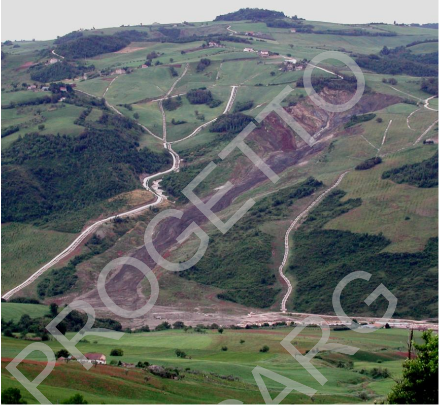
Fig. 20 - Frana in località Covatta.
