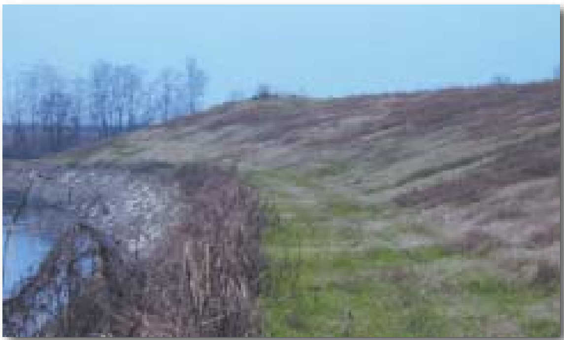
Figura 1.3.15: Ex discarica di Valera Fratta: scogliera di protezione in sponda idrografica sinistra del fiume Lambro che non mostra segni di danneggiamento.
