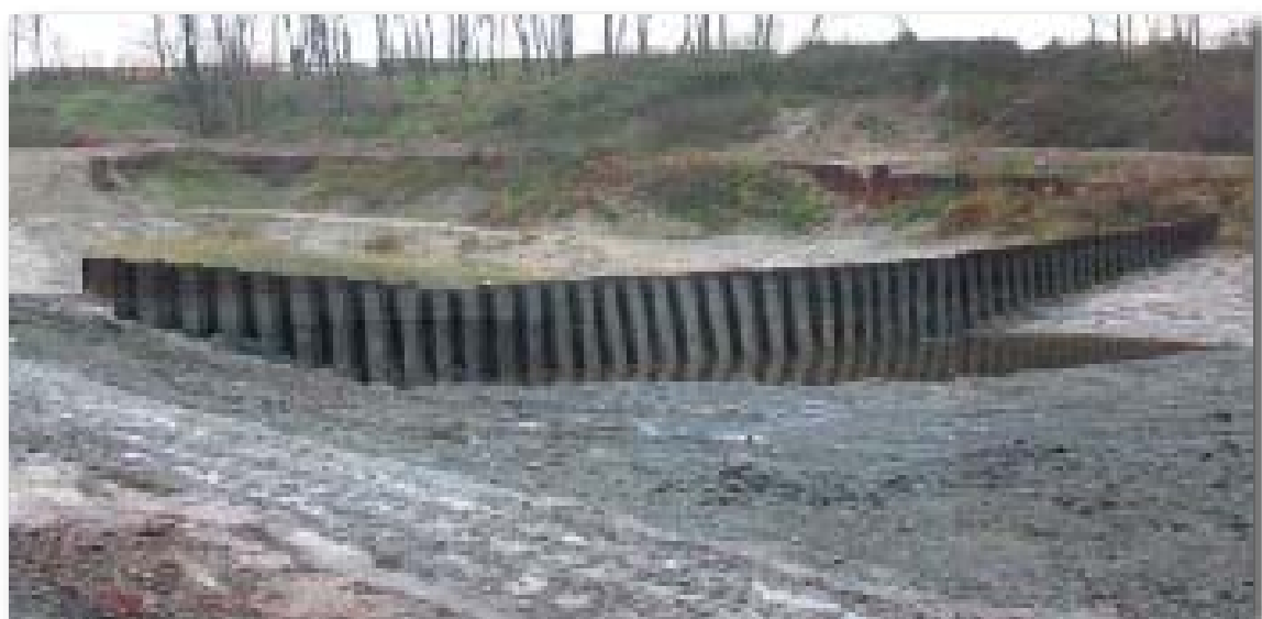
Figura 1.3.23: Palancolata divisoria tra l'area bonificata (a sinistra) e l'area in corso di bonifica (a destra)
