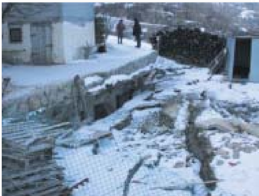
Figura 1.4.6: Paratia di pali realizzata per il consolidamento di una abitazione presso Colle Lapponi, sono visibili le fessurazioni prodotte dai movimenti franosi.
