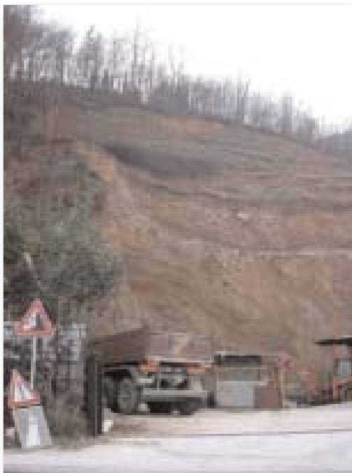
Figura 1.4.13: S.S. Venefrana. Sulla scarpata retrostante il bar affiorano terreni incoerenti ad elevata propensione al dissesto.
