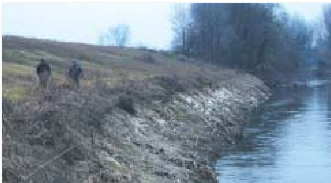
Figura 1.3.16:- Ex discarica di Valera Fratta: scogliera di difesa spondale situata alla base del rilevato della discarica ripresa da altra angolazione.
