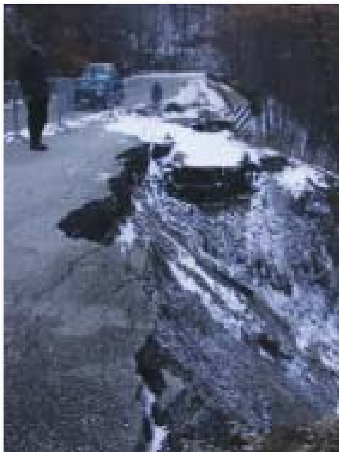
Figura 1.4.10: Tratto di ex S.S. N. 86 dismessa dall'ANAS, danneggiato dai fenomeni franosi.
