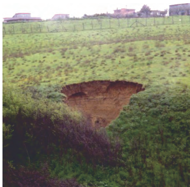
Fig. 3 - Sinkhole originatosi nei primi mesi del 2004 presso Monte delle Picche. Lo sprofondamento presenta una forma subcircolare con una larghezza media di circa 6 metri per una profondità stimata di 4 m. Ricade in un'area territoriale interessata dalla realizzazione di un insediamento a carattere prevalentemente residenziale (A.T.O. R 72) (foto: Succhiarelli C.).
