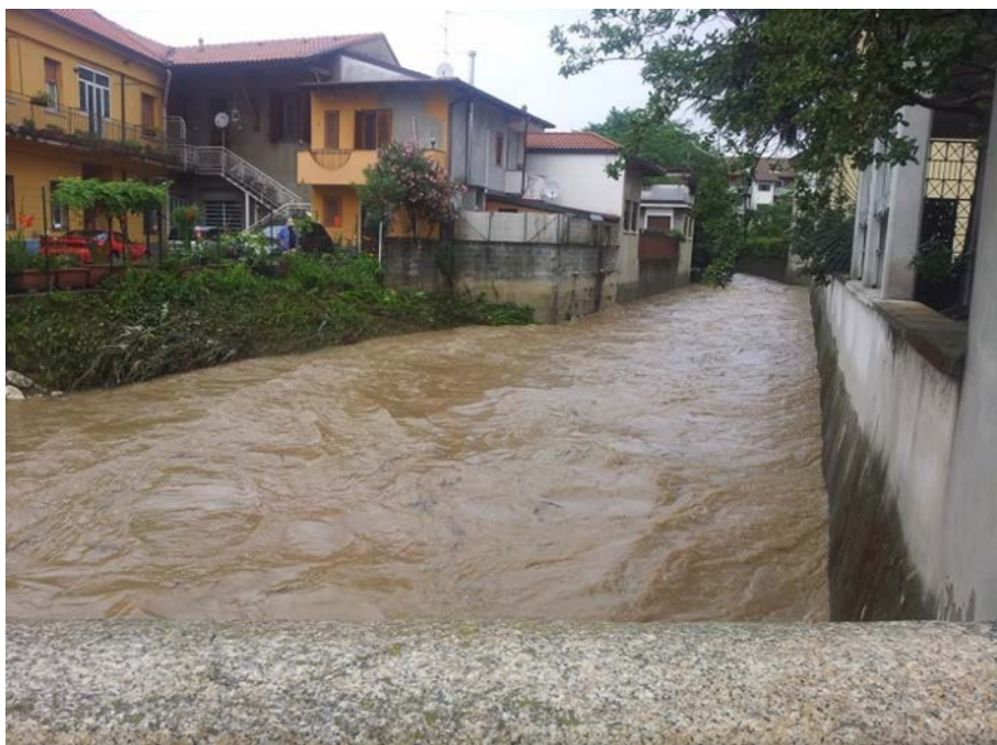
Foto 2.3.9 – Piena del Seveso nei pressi della periferia Nord di Milano. Restringimento dell'alveo fluviale, 15 novembre 2014 (Fonte: http://www.bovisiomasciagonews.net/ )
