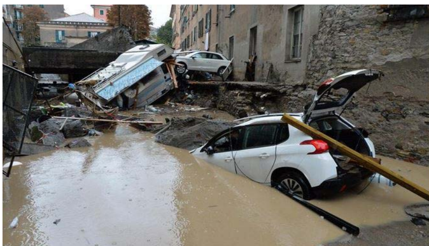
Foto 2.3.3 – Panoramica dei danni provocati dall'alluvione del 9-10 ottobre 2014 a Genova (Fonte: http://www.skytg24.it )
