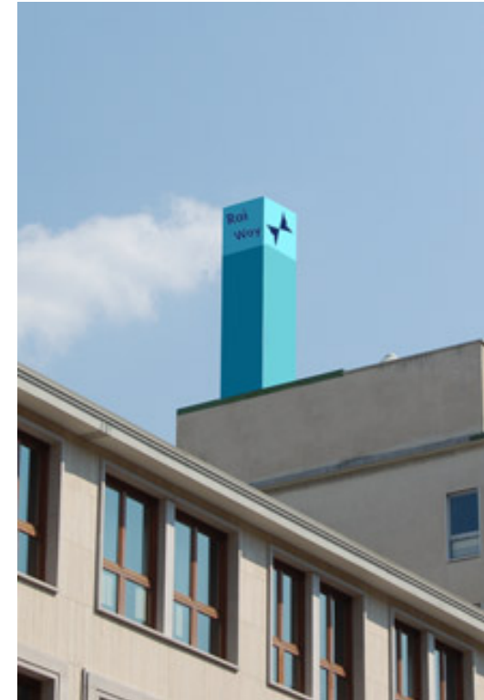
Esempio di stazione radio base mascherata con pannellatura
