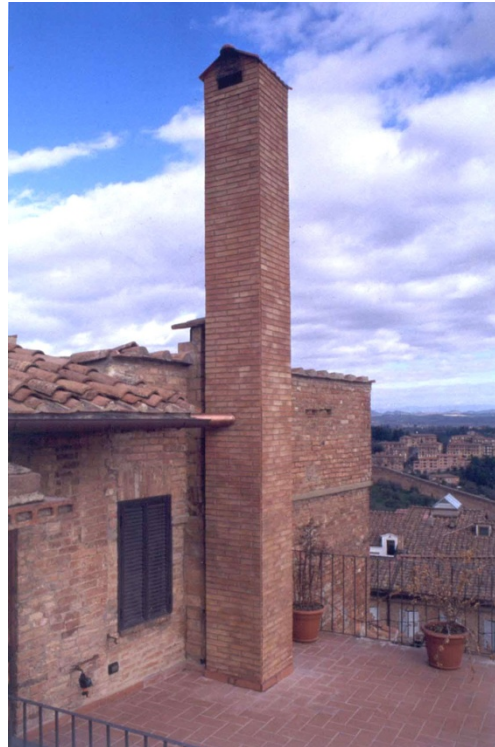
Esempio di stazione radio base mascherata da camino
