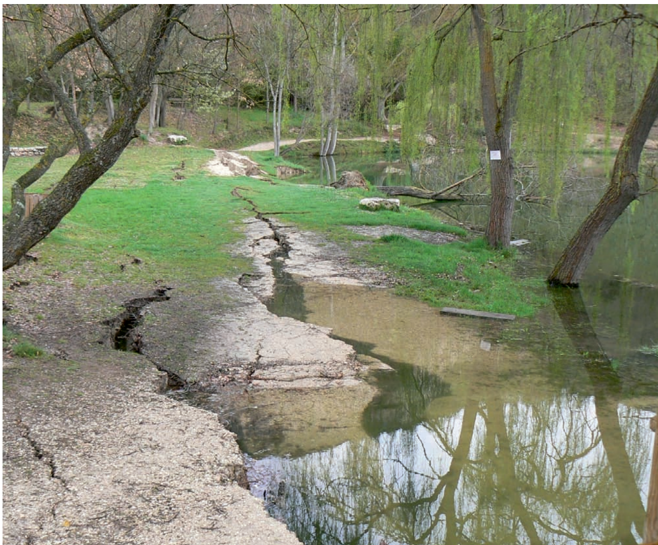
Fig. 6 - Dislocazioni e subsidenza della sponda del lago Sinizzo a San Demetrio nei Vestini, terremoto del 2009. - Dislocations and subsidence of the shore of Sinizzo lake in San Demetrio in Vestini, during the earthquake of 2009.
