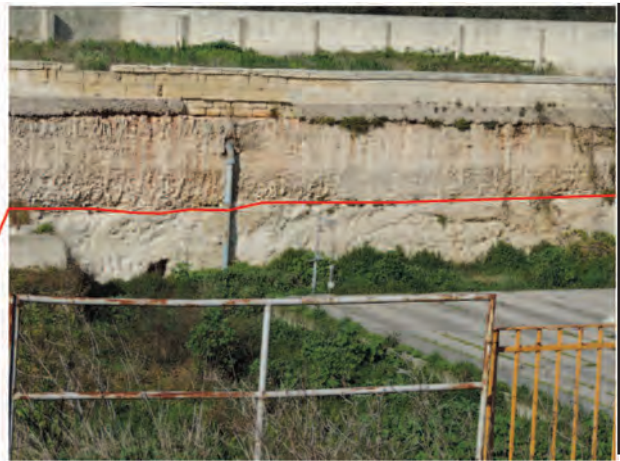
Fig. 7 – Stratigrafia ricavata dal sondaggio a carotaggio continuo realizzato in via Otranto (LIGORI, 2013). La foto mostra il contatto stratigrafico tra la calcarenite grossolana giallastra poco cementata (carparo o tufo) e la sovrastante calcarenite grossolana ben cementata (mazzaro) visibile in un affioramento nei pressi dell'abitato di Cutrofiano.
