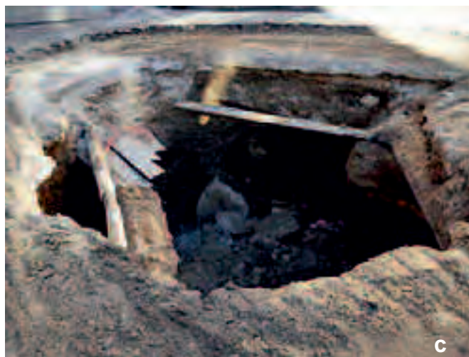
Fig. 1 – Alcuni immagini di Sinkhole antropogenici: a – Ariccia (RM), crollo legato a rottura impianto fognario; b – Esperia (FR), esplosione tubatura idrica; c – Rieti, perdita rete idrica fatiscente; d – Terracina (LT) sprofondamento a seguito di piogge intense; e – Viterbo, sprofondamento legato a cavità sotterranea e successiva perdita idrica.
