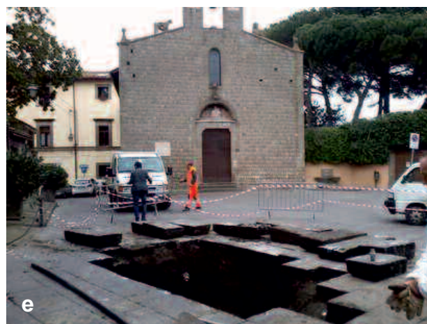
Fig. 1 – Alcuni immagini di Sinkhole antropogenici: a – Ariccia (RM), crollo legato a rottura impianto fognario; b – Esperia (FR), esplosione tubatura idrica; c – Rieti, perdita rete idrica fatiscente; d – Terracina (LT) sprofondamento a seguito di piogge intense; e – Viterbo, sprofondamento legato a cavità sotterranea e successiva perdita idrica.
