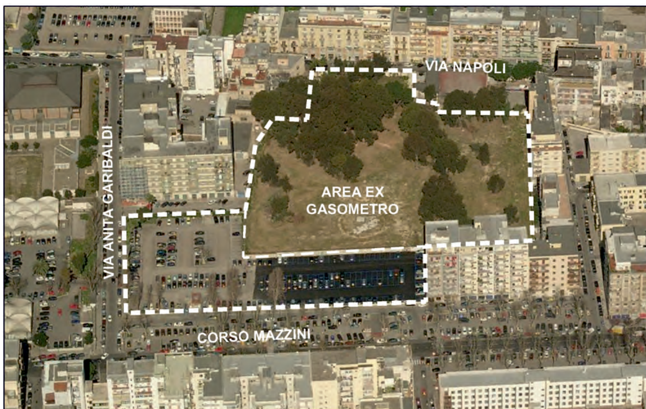
Fig. 19.15 - Area dell'ex Gasometro di Bari (anno 2011) (da Maps.Google.com). - Area of the former Gasometer of Bari (year 2011; source: Maps.Google.com).
