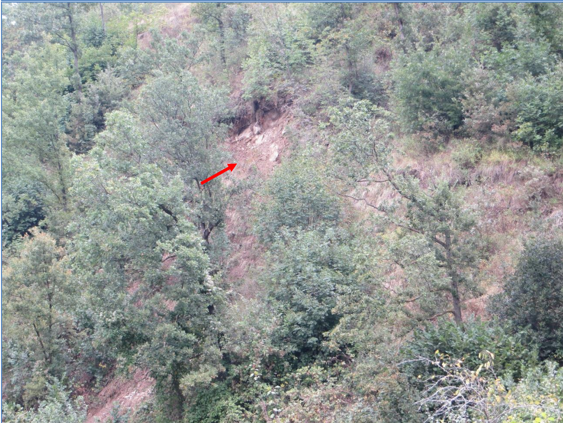
Ristorante e casa sottostanti al versante oggetto del crollo (avvenuto poco a sud degli edifici) (foto sopra). Dettaglio del punto di distacco (foto sotto)
