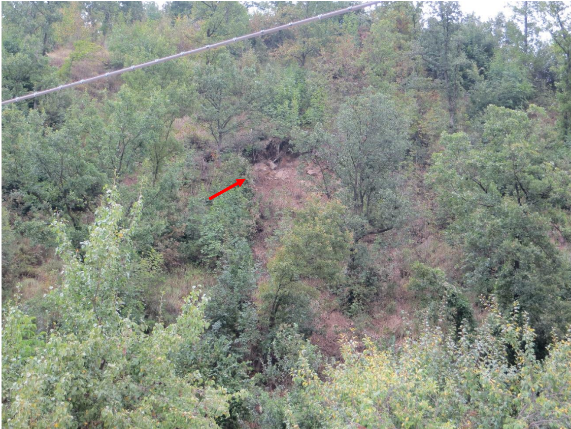
Versante oggetto del crollo. La zona di distacco è seminascosta dalla fitta vegetazione.
