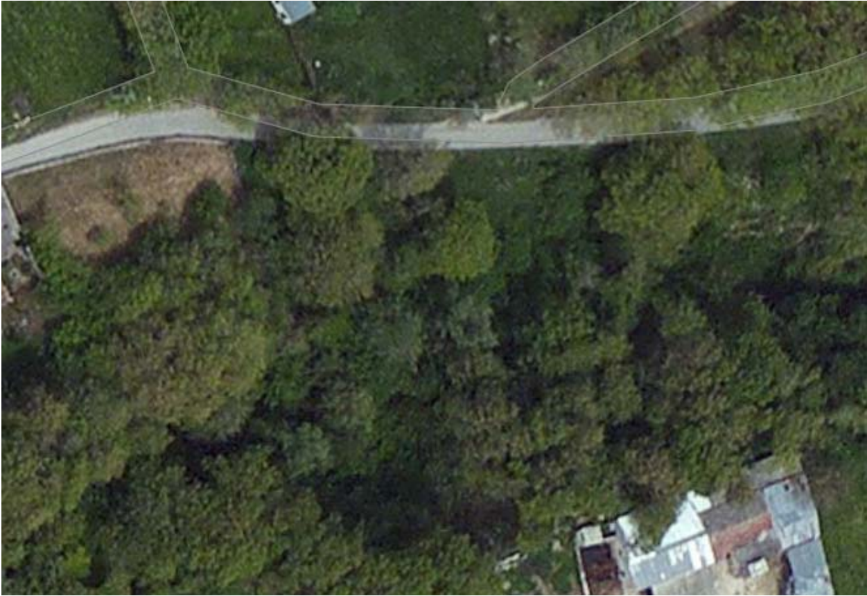
Dettaglio del versante prima dell'occorrenza dell'evento franoso (Fonte Bing Maps).
