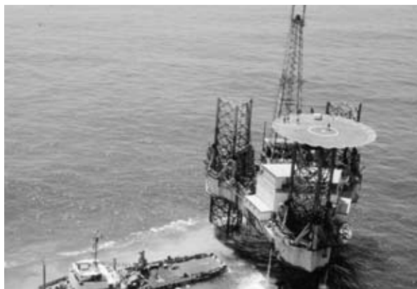
Fig. 4 - Piattaforma di perforazione offshore.
