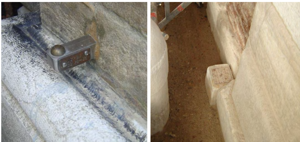
Figura 2.12 – Capisaldi di livellazione per la definizione del TGBM in prossimità della stazione mareografica di Punta della Salute (ISPRA - Rete Mareografica della Laguna di Venezia e del litorale Nord-Adriatico). A sinistra: caposaldo verticale posto su una parete di un edificio. A destra: caposaldo orizzontale posizionato su un cippo.
