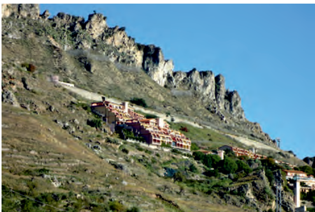
Fig. 532 - Versante meridionale della dorsale di Forza d'Agro (provincia di Messina). Il costone subverticale di calcari giurassici, interessato da fitti sistemi di fratture, incombe su un complesso alberghiero ed altri edifici. - Southern slope of the Forza d'Agro ridge (province of Messina). The subvertical Jurassic limestone, affected by dense systems of fractures, hanging over a hotel complex and other buildings.
