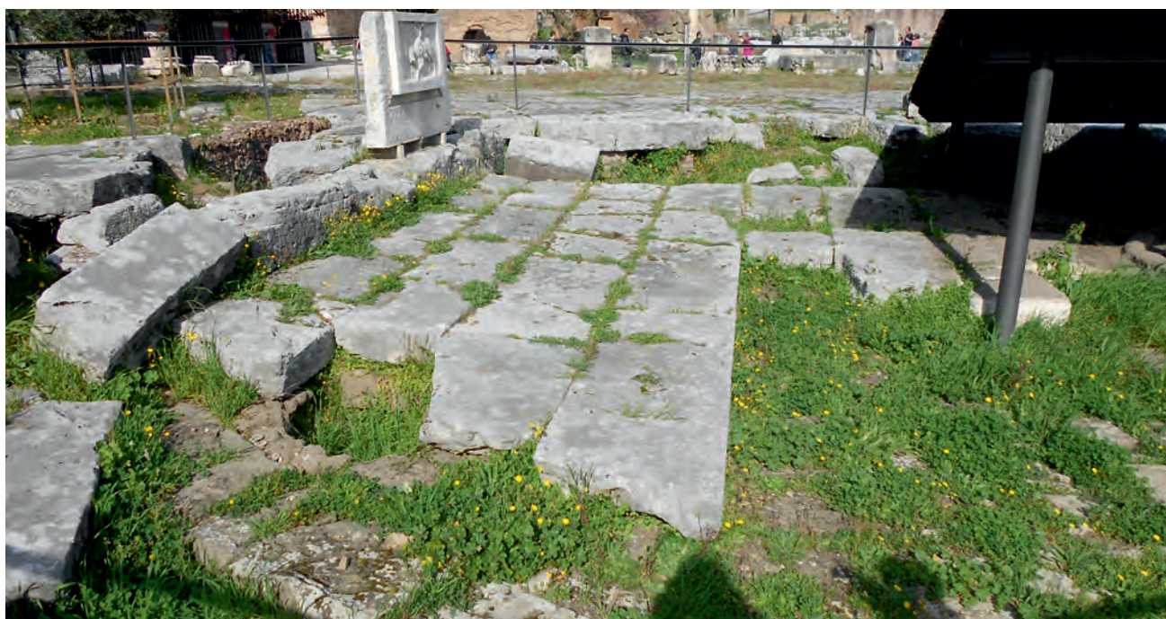
Fig. 14 – Lacus Curtius , avvallamento e ribassamento del suolo che fa ipotizzare movimenti successivi alla pavimentazione del sito. – Lacus Curtius , depression and lowering of the ground that confirm the movements in the site.
