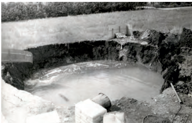
Fig. 4 – Sinkhole verificatosi nel marzo 1992, a seguito di una perforazione per ricerche idriche presso lo stabilimento Pettinicchio (via Appia, loc. Tor Tre Ponti). Dopo aver raggiunto i calcari si sono avuti fenomeni di franamento delle pareti del pozzo, probabilmente per fenomeni di liquefazione a carico delle frazioni più sabbiose, (foto: Carlomagno).
