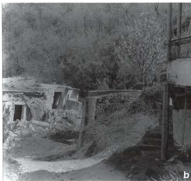
Fig. 59. – Lettomanoppello in provincia di Pescara. a ) Orlo del versante nord-occidentale; consolidamenti sul ciglio di un movimento franoso tuttora attivo. Tra il 1954 e il 1968 i dissesti in questa zona costrinsero ad abbattere circa 80 fabbricati. b ) Il basso versante, sede di rimobilizzazione di movimenti franosi per scorrimenti rotazionali e colamenti ancora attivi nel 1987. I fabbricati visibili sono dissestati o distrutti da franamenti pregressi ( fotografie dell'autore, 9 aprile 1987 ).
