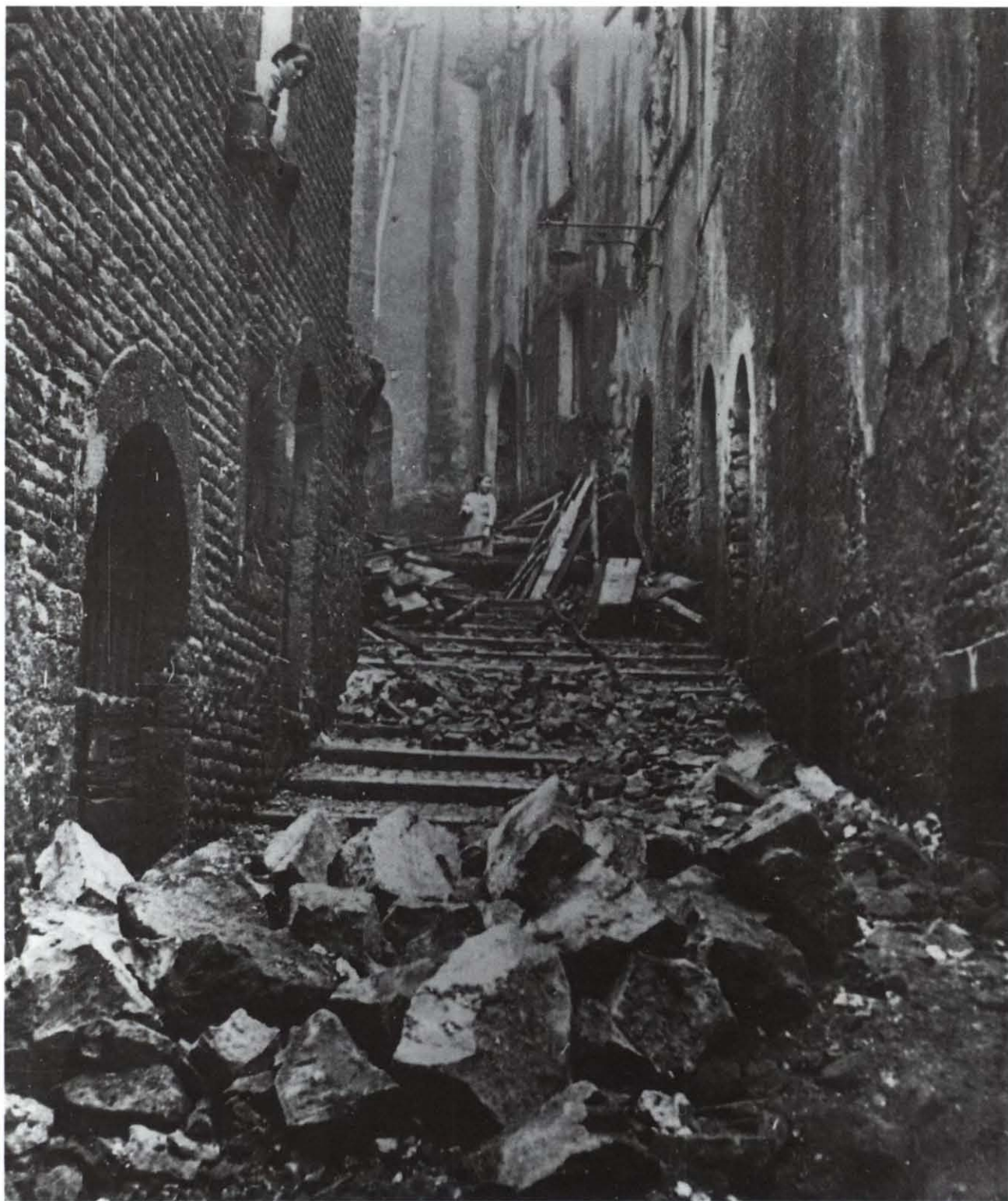
Fig. 57. – Aspetto del danneggiamento a Teramo, terremoto del 5 settembre 1950 ( gentile concessione ANSA ). – Earthquake damage in the Teramo city, September 5, 1950.
