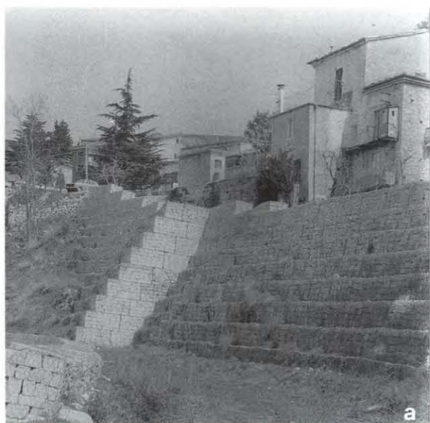
Fig. 59. – Lettomanoppello in provincia di Pescara. a ) Orlo del versante nord-occidentale; consolidamenti sul ciglio di un movimento franoso tuttora attivo. Tra il 1954 e il 1968 i dissesti in questa zona costrinsero ad abbattere circa 80 fabbricati. b ) Il basso versante, sede di rimobilizzazione di movimenti franosi per scorrimenti rotazionali e colamenti ancora attivi nel 1987. I fabbricati visibili sono dissestati o distrutti da franamenti pregressi ( fotografie dell'autore, 9 aprile 1987 ).
