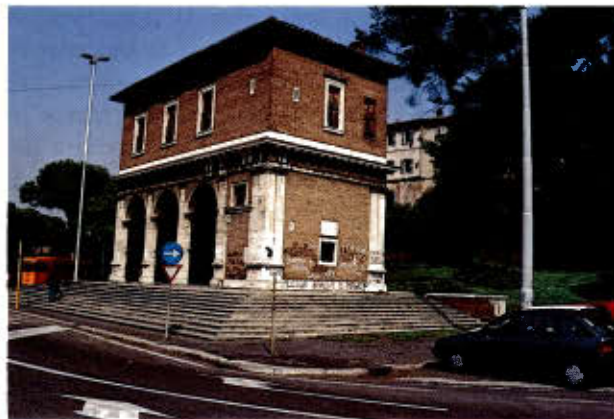
Fig. 16 – Acqua di Mercurio: edificio a Piazza di Porta Capena ove è collocata la lapide commemorativa della sorgente.
