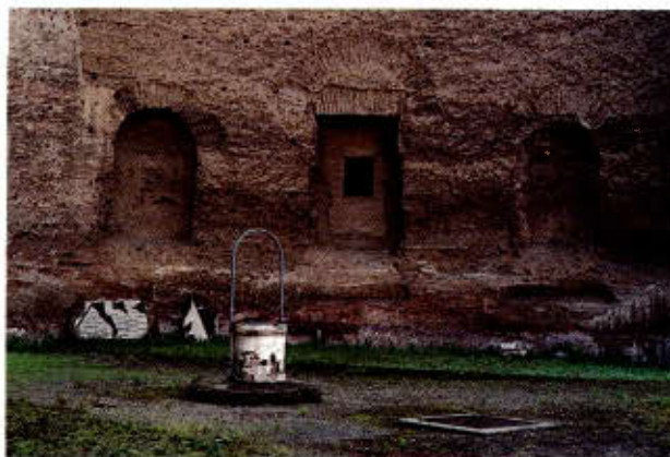
Fig. 17 – Piscina Publica: pozzo con vera posto nella palestra settentrionale delle Terme di Caracalla. Il pozzo permetteva il prelievo dell'acqua dalla fogna principale dell'edificio nella quale scorreva e scorre tuttora acqua di falda.
