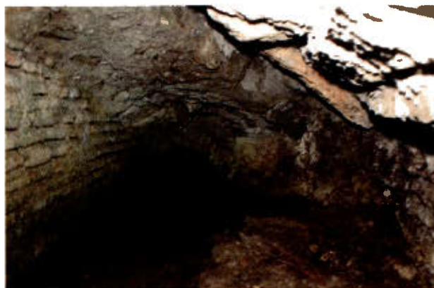
Fig. 9 – Acque Corsiniane: sbocco del cunicolo romano di drenaggio della sorgente n. 5.
