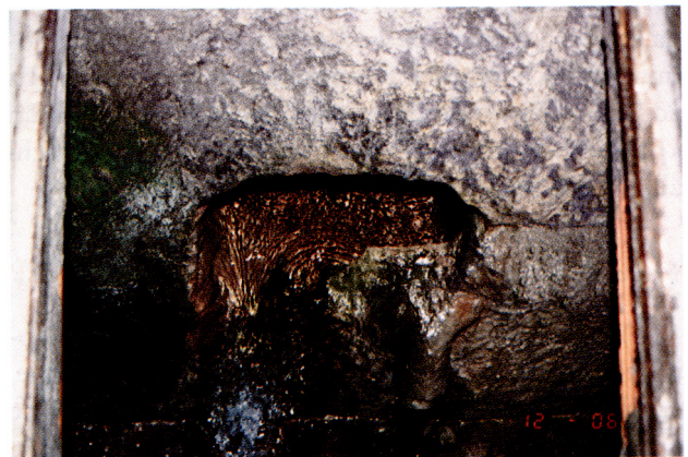
Fig. 15 – S. Clemente: condotto di epoca romana dal quale fuoriesce l'acqua.
