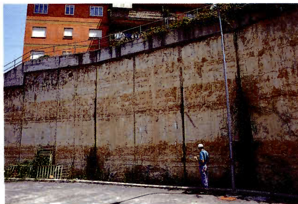
Fig. 25. – Le argille dell'Unità di Monte delle Piche affioranti lungo un muro di contenimento in Via Portuense, all'incrocio con Via Affogalasino. La quota del p.c. è di circa 33 m s.l.m.
