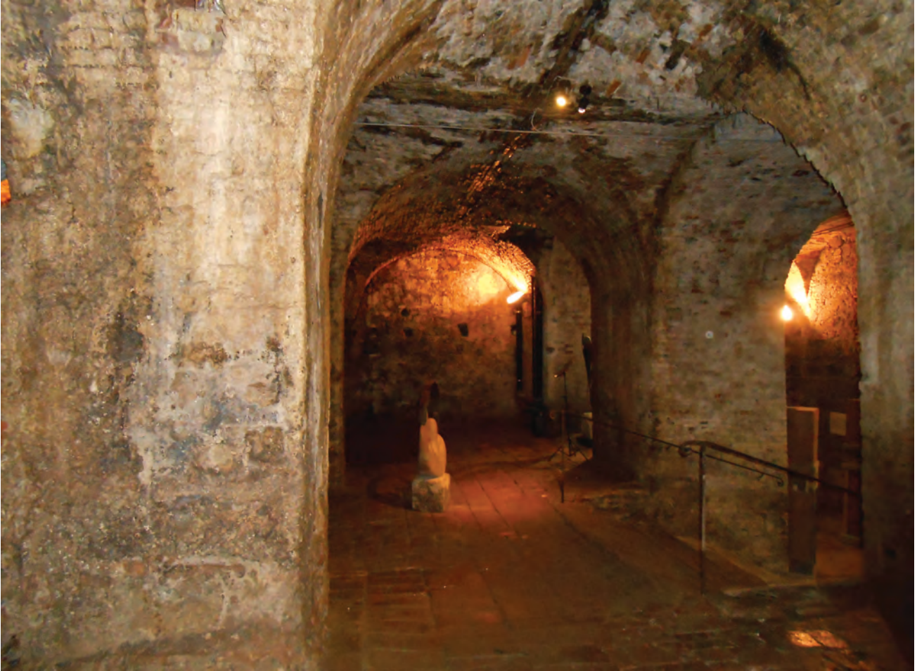
Fig. 13 - Ambienti sotterranei della città di Rieti. - Underground rooms in the Rieti town.
