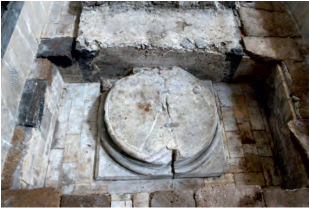
Fig. 8 - Base di una colonna della Cattedrale crollata durante il terremoto del 1693. - Base of a column of the Cathedral collapsed during the earthquake of 1693.
