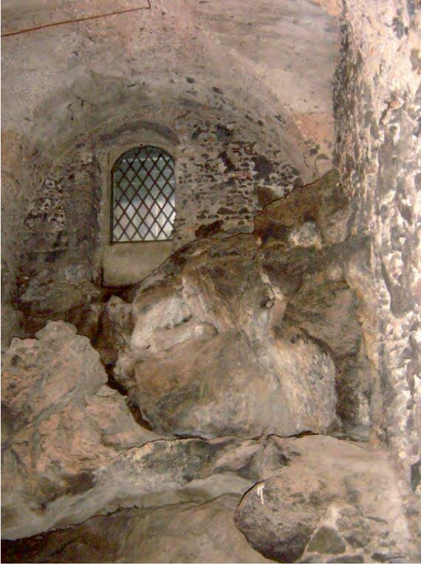
Fig. 15 - Muri delle cantine del Monastero dei Benedettini impiantati direttamente sul banco lavico del 1669. - Walls of the cellars of the Benedictine Monastery implanted directly on lava of 1669.
