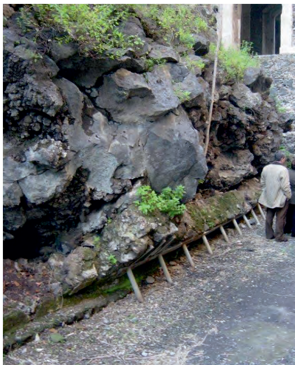
Fig. 14 - Bancone lavico del 1669 in contatto con le mura antiche nei pressi del Monastero dei Benedettini. - Lava of 1669 in contact with the ancient walls near the Monastery of the Benedictines.
