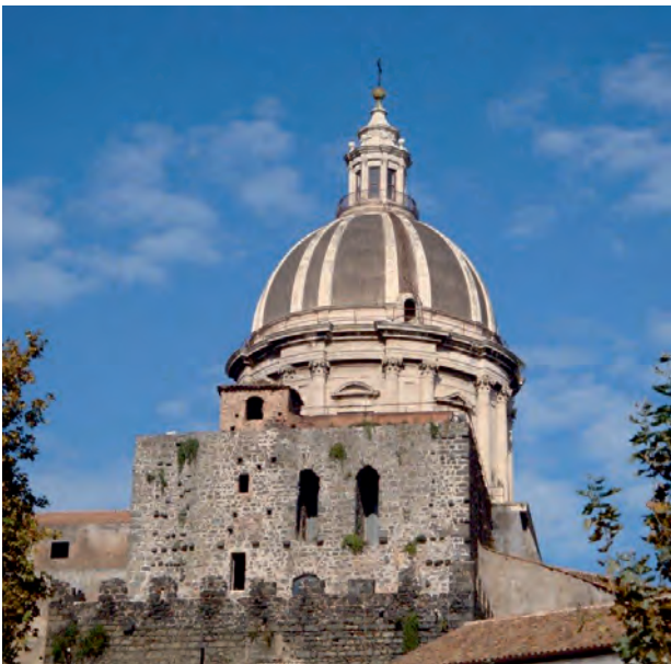
Fig. 9 - Merlature, feritoie e finestre con archi ogivali nella parte della Cattedrale sopravvissuta al terremoto del 1693. - Crenellations, embrasures and windows with pointed arches in the part of the Cathedral survived the earthquake of 1693.
