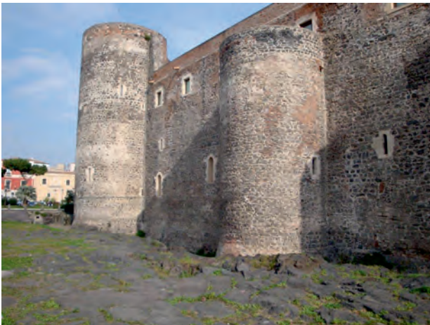
Fig. 11 - Facciata occidentale del Castello Ursino investita dalla lava del 1669. - Western facade of the Castello Ursino invested by the lava of 1669.
