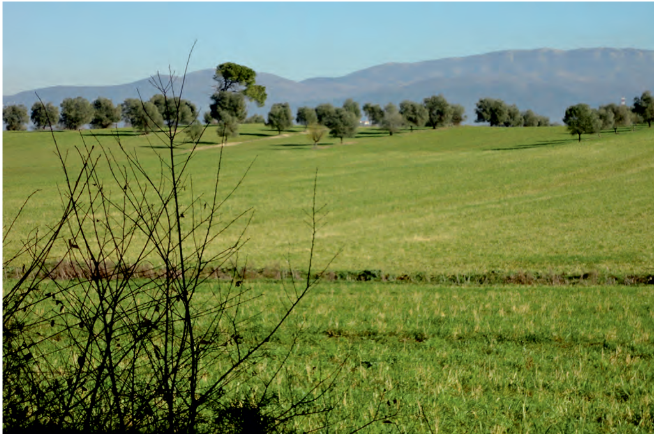
Fig. 9 - Panoramica dell'area dove si è originato un cover collapse sinkhole, oggi ricolmato. - Overview of the area where is originated a cover collapse sinkhole, now filled.
