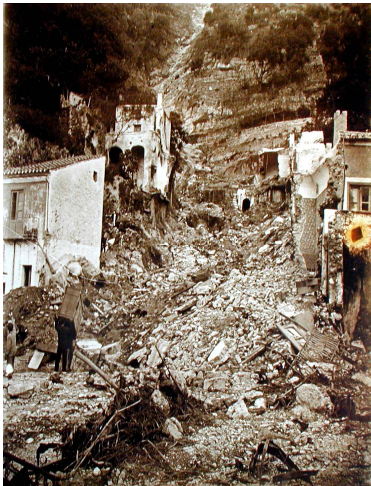
Figura 2.4 Frana in località Suora Clara, Cetara 1910.
