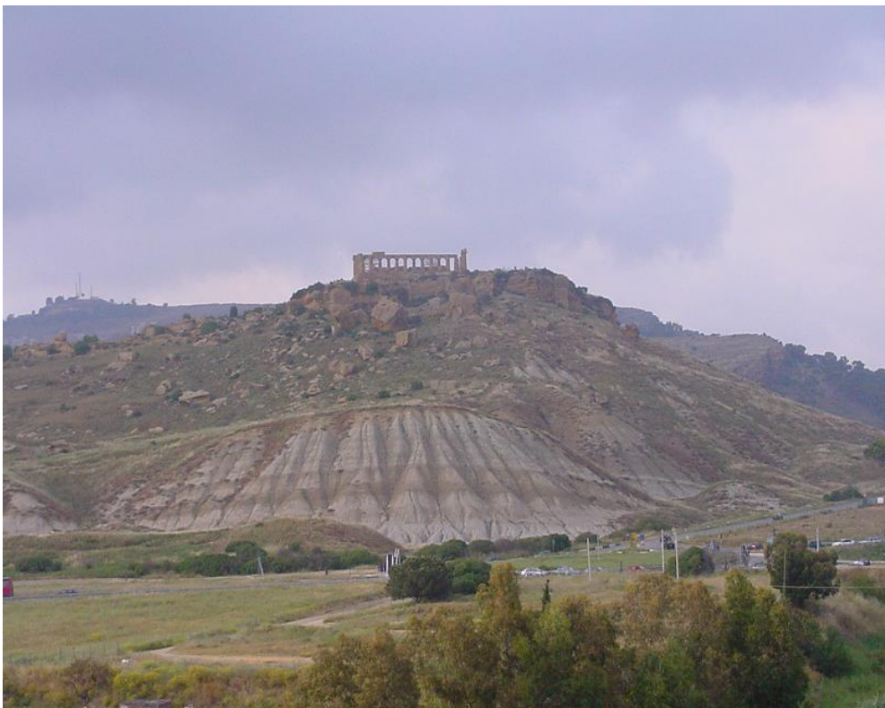
Figura 24.6 Panoramica della frana del Tempio di Giunone (id: 0841210700).
