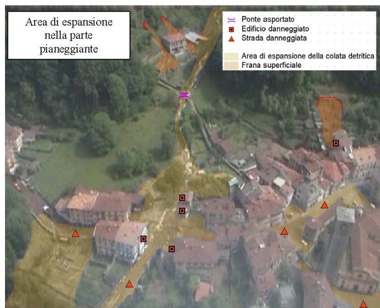
Figura 5.14 Esempio di area di espansione di un Debris Flow.
