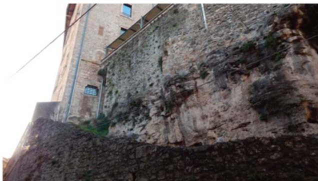
Fig. 8 - Esempio delle ottime caratteristiche dei calcareous tufa che costituiscono la rupe di Rieti: banchi spessi anche alcuni metri a volte sottilmente laminati compatti, costituiti da calcari miciritici, alternati a livelli più porosi con facies fitoclastiche o fitoemali.
