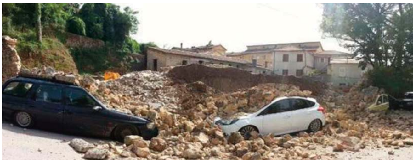
Fig.13 - Crollo di un muro in via della Cavatella a Rieti, 4 luglio 2014. - Collapse of a wall in via della Cavatella in Rieti, 4 July 2014.
