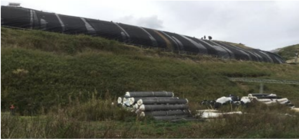
Figura 6. Il rilevato in terra rinforzata visto da valle
