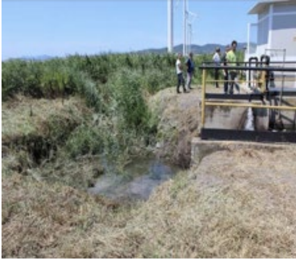
Figura 43. Fossa campereccia presso scarico SF4
