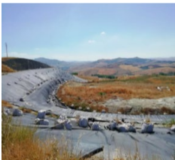
Figura 24. Riprofilatura della vasca B2
