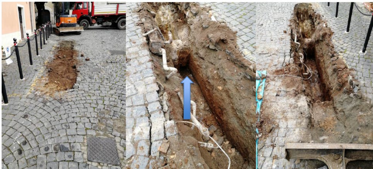
Figura 72. Predisposizione e realizzazione della trincea esplorativa
