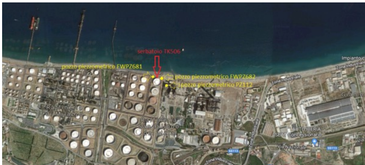
Figura 53. Ubicazione del serbatoio “TK 506” della Raffineria “RM” e dei tre pozzi piezometrici dove è stato rilevato il gasolio surnatante
