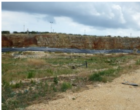
Figura 10. Il lotto III e le scarpate laterali coperte
