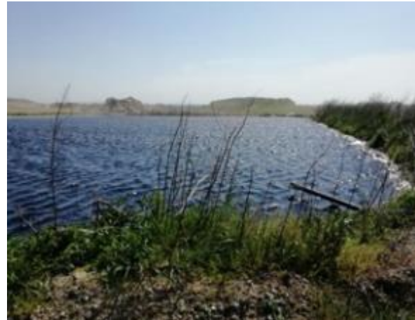
Figura 19. L'invaso temporaneo per la raccolta del percolato realizzato sul corpo rifiuti
