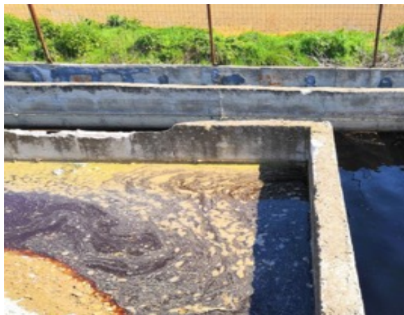
Figura 17. Particolare dell'intersezione tra i canali sud e est in cui è visibile del percolato
