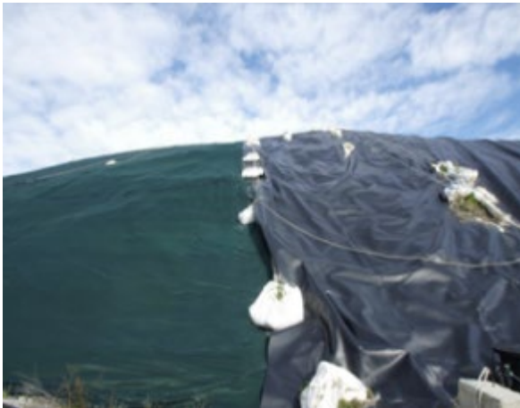
Figura 3. Stato della copertura del corpo rifiuti
