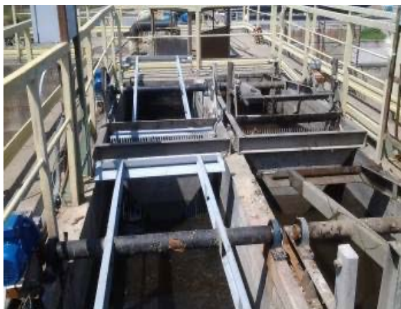
Figura 67. Vasche di grigliatura.
