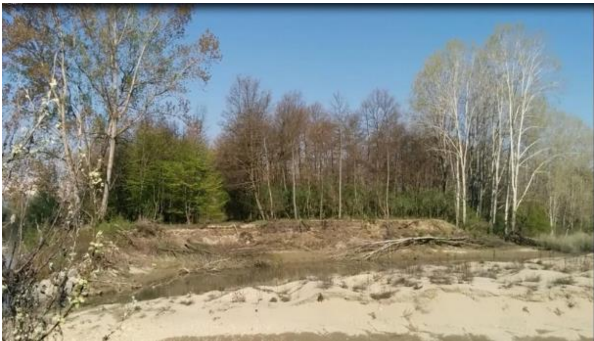
Figura 78. Varco di collegamento tra fiume Po e lago di cava, in primo piano il cumulo di materiale residuale
