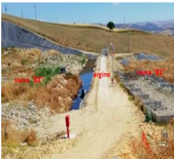
Figura 26. Argine di separazione tra le due vasche e bacino di raccolta
