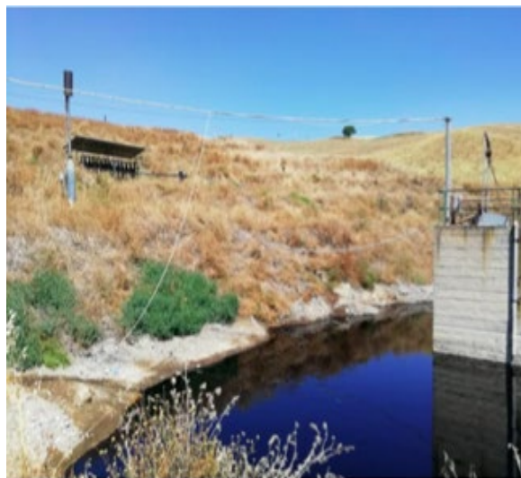
Figura 27. Vista parziale del laghetto con torrino
