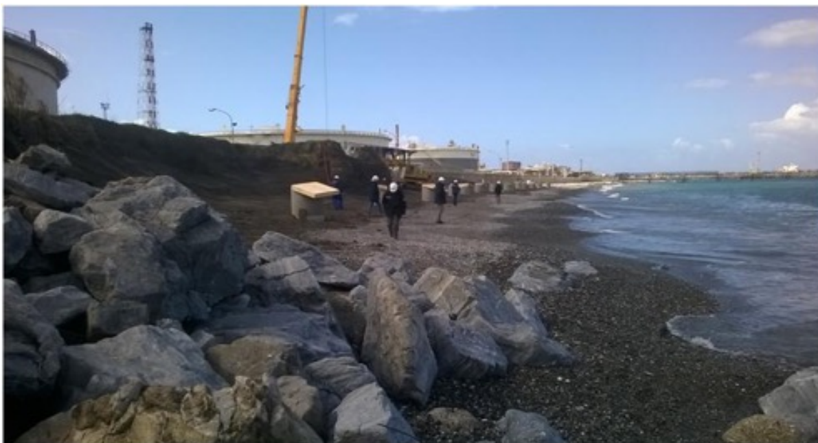
Figura 54. Trincea drenante realizzata lungo l'arenile in corrispondenza del serbatoio "TK 506"
