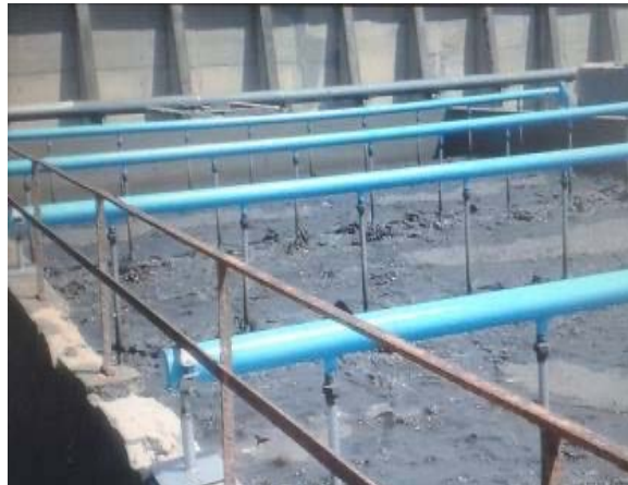
Figura 68. Tubazioni di insufflazione aria ripristinate
