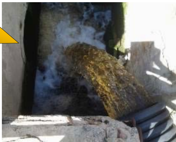
Figura 66. Il pozzetto finale di scarico a mare con la condotta di recapito del refluo depurato
