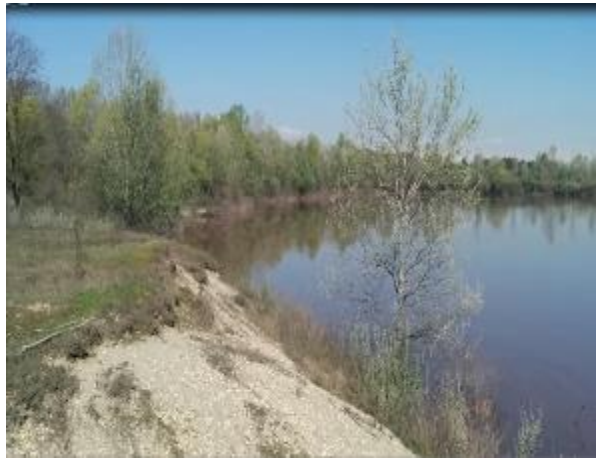
Figura 77. Il profilo spondale sul lato Sud
