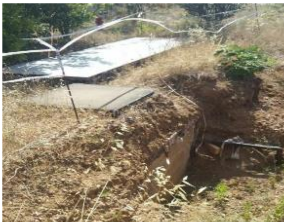
Figura 61. Il serbatoio interrato ex impianto CO.NU.-MAGNOX e l'area di scavo adiacente
