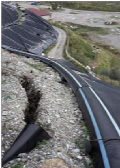
Figura 5. Particolare della zona di scivolamento verso valle di una porzione dei rifiuti
