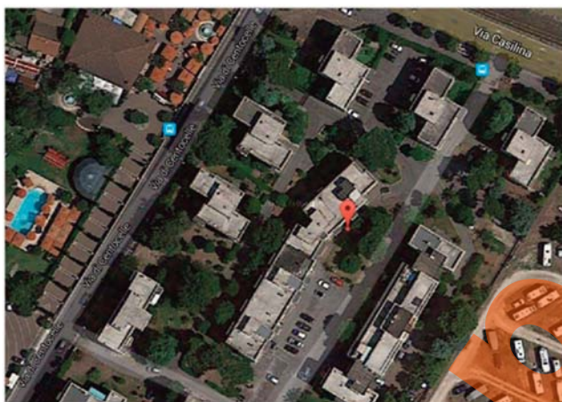
Fig. 20 - Ubicazione del sinkhole originatosi nel 2016, presso via Centocelle 3. - Location of the sinkhole collapse occurred at via Centocelle 3 in 2016.
