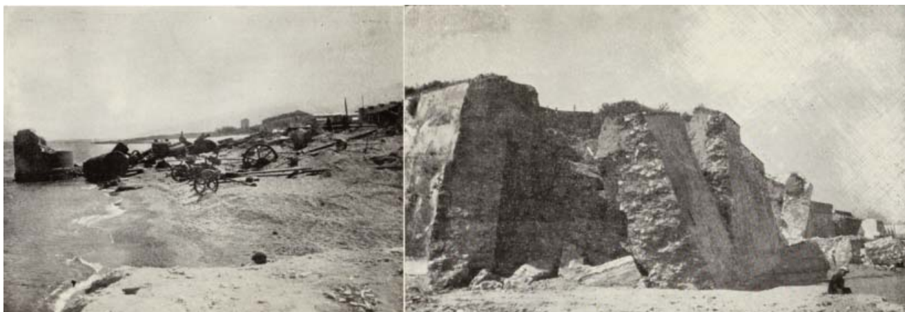
Fig. 6 - La ferriera Gioia e Tedeschi (a sinistra) raggiunta del mare dopo gli effetti combinati di terremoto e maremoto e (a destra) i danni subiti dal Bastione Don Blasco (FRANCHI, 1909).
