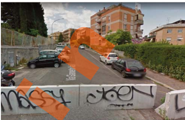
Fig. 27 - Via Giannetto Valli strada chiusa per problemi di cedimento e sprofondamento.
